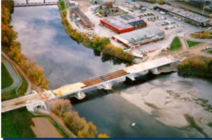
1950年に建設されたシェアブルークにあるジョップルブリッジは、メインガーターとデッキの厚板の劣化が進んだ。シェアブルーク市とケベック運輸省は、1997年に橋のデッキの再築を決定した。主な目的はデッキの修復のみならず、光ファイバーセンサーによる遠隔地からの観察や、FRPによる橋の補強、そして光ファイバーセンサーの使用の可能性を証明することにあった。
